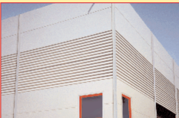
Detail van een voeg van de combinatie isowelle® en isowand Vario®
